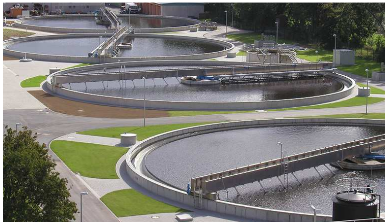
FIG. 3 – décanteurs dans une station d'épuration
