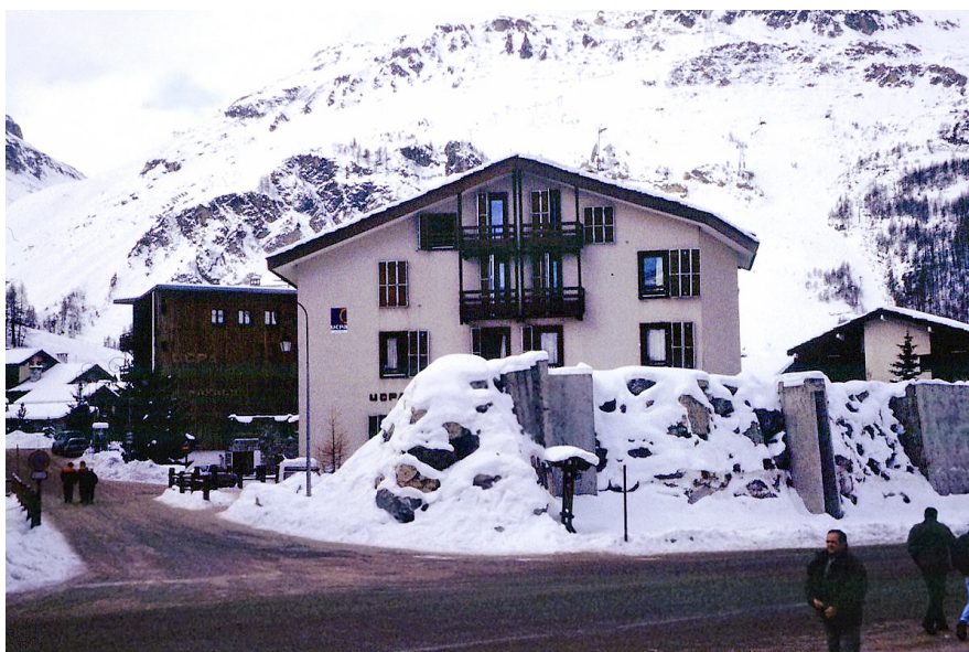
Figure 2. Chalet de l'UCPA de nos jours, protégé par un mur anti-avalanche. Cliché : Marc Givry.
