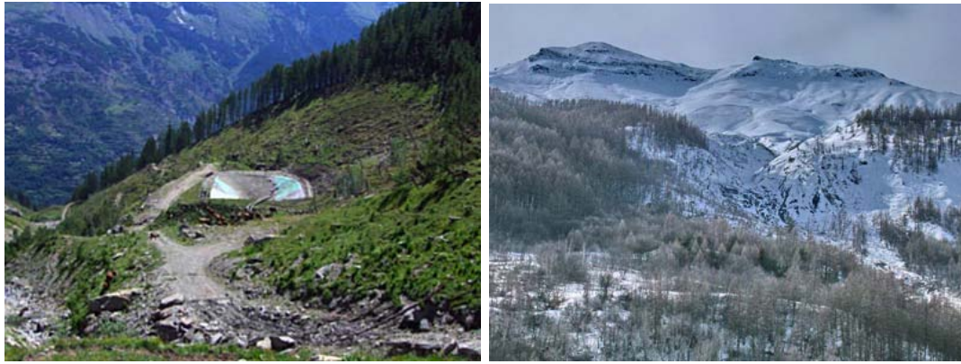
Figure 5.6 : avalanche du 9 mars 2006 détruisant la retenue de la station de Pelvoux (Hautes-Alpes, France) situé dans le bassin-versant de la Bouisse.
