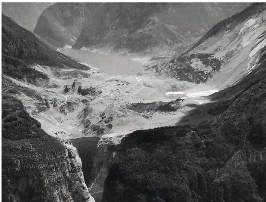
Figure 5.2 : barrage du Vajont après le mouvement de terrain du 9 octobre 1963.
