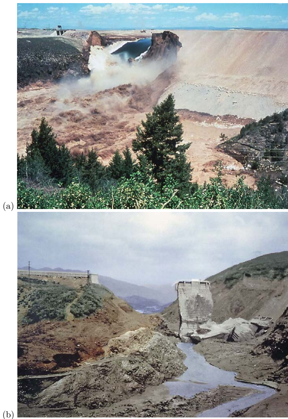
Figure 5.4 : rupture du barrage en terre de Teton (Idaho) en 1976. (b) Ruines du barrage de Saint-Francis (Californie) en 1928. [DR].
