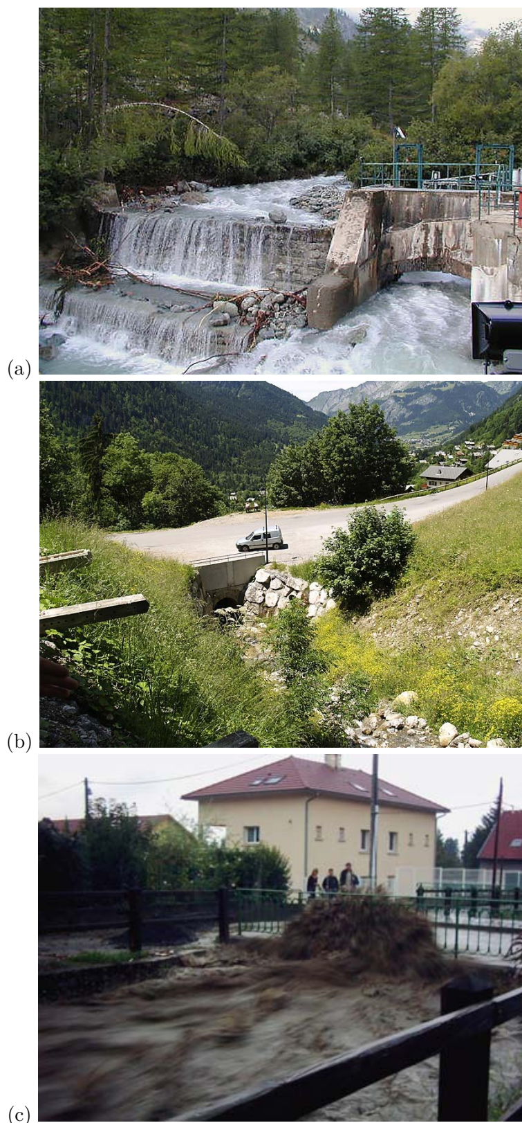
Figure 1.7 : (a) seuil avec prise d'eau pour la production électrique. (b) Passage busé sous une chaussée [C. Ancey]. (c) Crue du Doménon (Isère, France) en août 2005.
