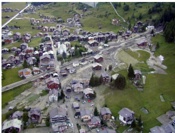
Figure 5.7 : le village de Täsch après la crue du Töschbach en juin 2001. Source : Crealp.
