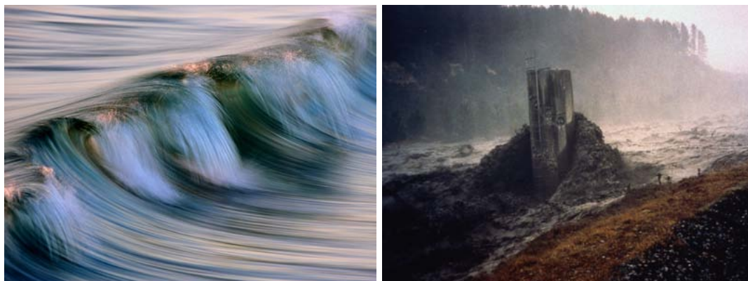
Figure 6.6 : (a) déferlement d'une vague (la vitesse en crête étant supérieure à la vitesse en pied de vague, la vague finit par se recroqueviller sur elle-même, provoquant un « déferlement »). (b) Impact d'une vague sur une culée de pont (détruit lors de la crue) sur la rivière Whanguehu en Nouvelle-Zélande [DR].
