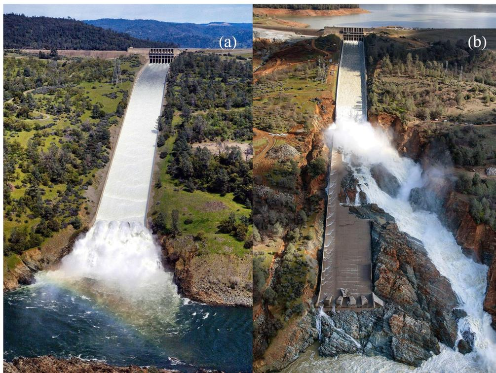
**Figure 5.53** – Évacuateur de crue du barrage d'Oroville (Californie) avant (a) et après (b) la crue de février 2017. Source : [California Department of Water Resources](#).
