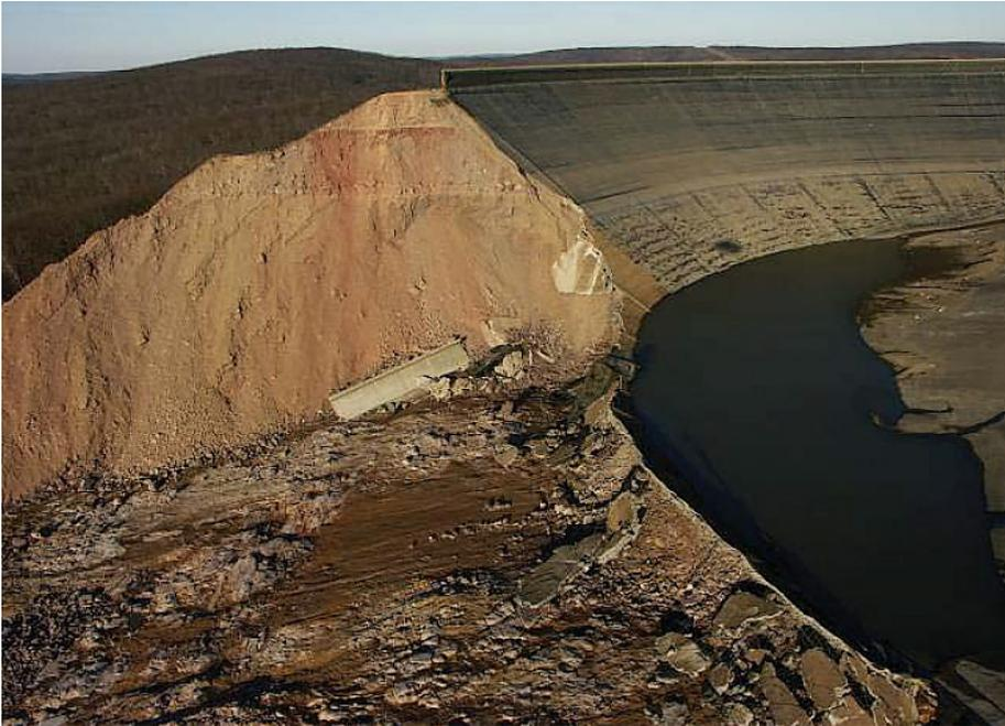
Figure 3.16 – Vue de la brèche dans le remblai de la retenue de Taum Sauk.
