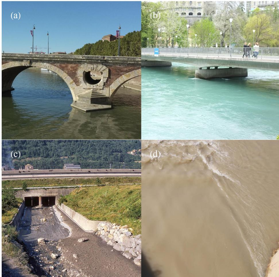
**Figure 1.17** – Différents types de passages couverts. (a) pont sur la Garonne à Toulouse (France). On notera les ouvertures aménagées au-dessus des piles du pont pour laisser transiter l'eau lors des crues ; (b) passerelle sur l'Aar à Berne ; (c) dalot sous l'autoroute A43 en Maurienne (France) ; (d) ressaut au passage entre deux piles du pont de Cordoue enjambant le Guadalquivir (Espagne).
