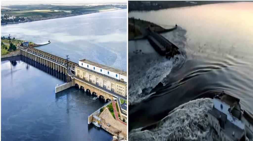
**Figure 3.1** – Rupture du barrage de Kakhovka sur le Dniepr (Kherson, Ukraine) le 6 juin 2023. Le barrage a été détruit par une explosion, le plus vraisemblablement prévue par l'armée russe pour inonder la région de Kherson et ainsi ralentir une contre-offensive ukrainienne. Le volume de la retenue  $18 \times 10^9$  m<sup>3</sup> fut drainé en quatre jours. Source : [Youtube](#).
