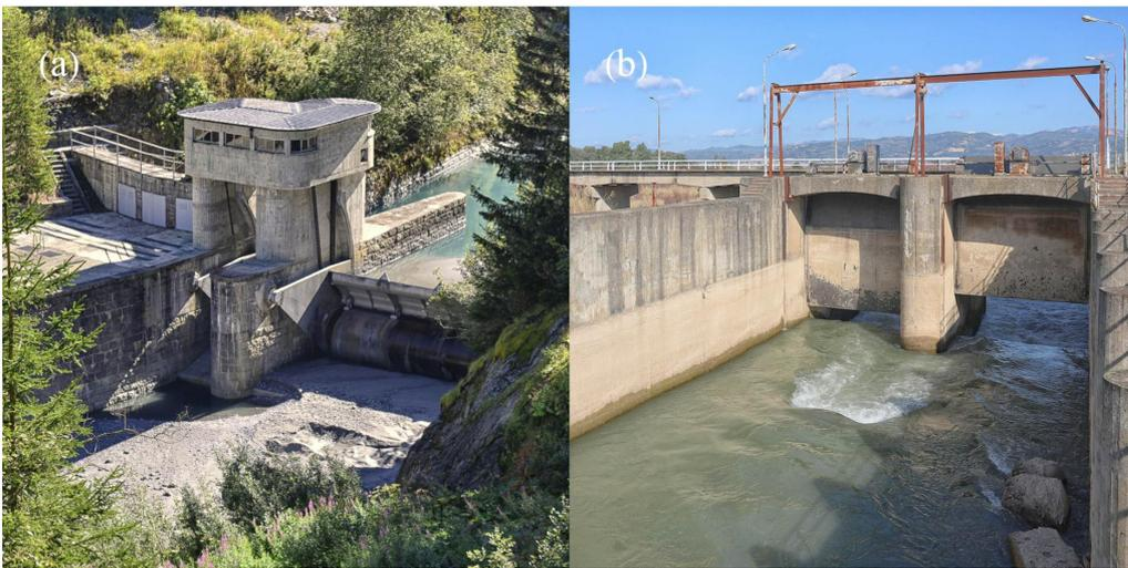
**Figure 1.16** – Différents types de vanne. (a) vanne secteur sur la Dranse à Fionnay (VS); (b) vanne plane sur l'Alphée à Olympie (Grèce).
