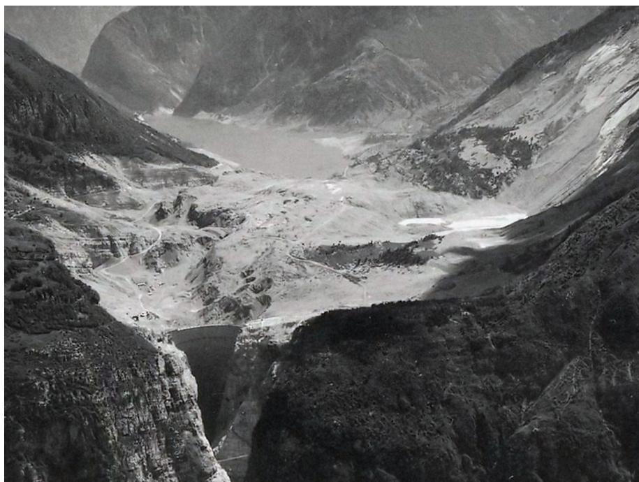
Figure 3.4 – Barrage du Vajont après le mouvement de terrain du 9 octobre 1963.
