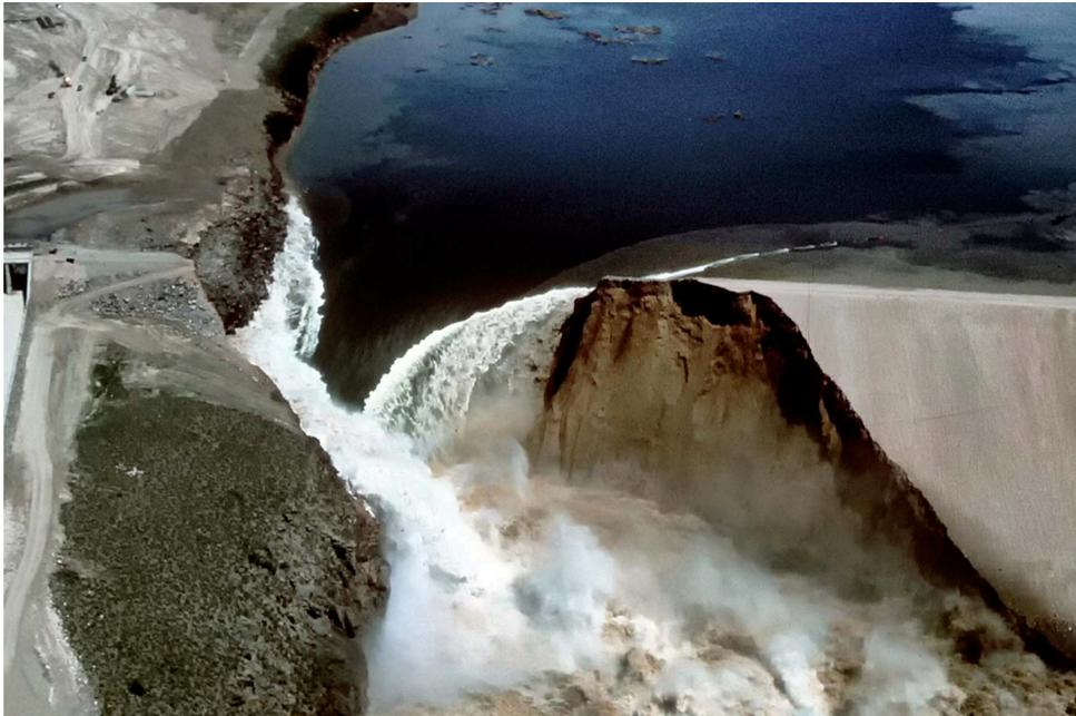
**Figure 3.8** – Rupture du barrage en terre de Teton (Idaho) le 5 juin 1976. Source : [Wikimedia](#).
