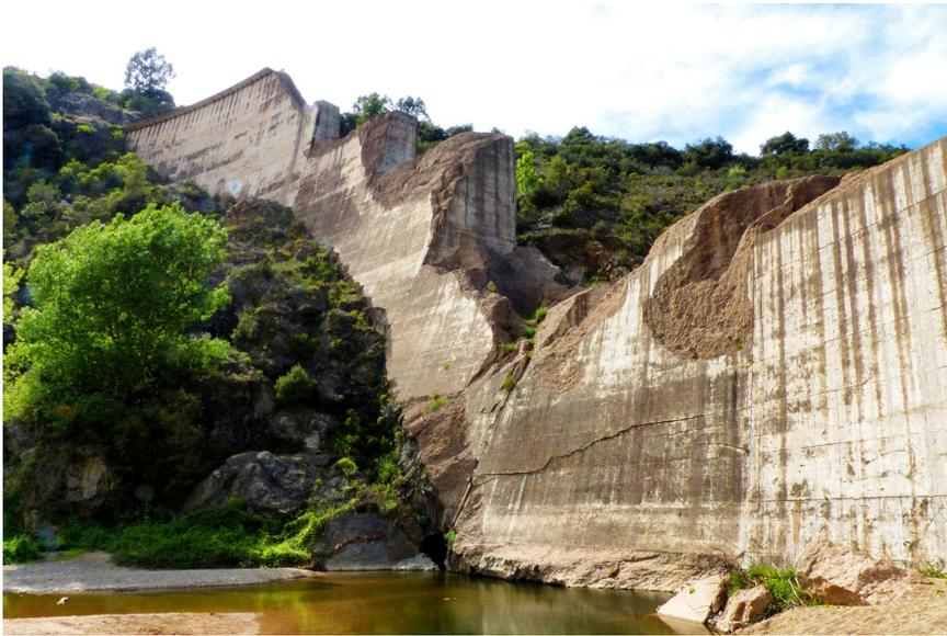
Figure 3.15 – Brèche dans la voûte du barrage de Malpasset. Source : [wikimedia](https://commons.wikimedia.org/wiki/File:Malpasset_Dam.jpg).
