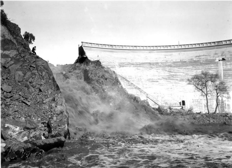
**Figure 3.2** – Érosion des berges contre lesquelles s'appuyait le barrage de Sweetwater en 1916.
