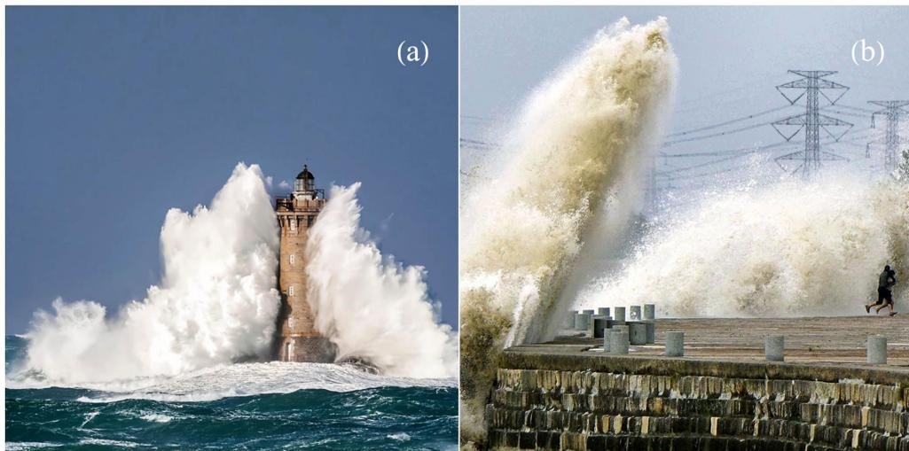
**Figure 4.4** – (a) Déferlement d'une vague sur le phare d'Argenton-en-landunvez (Bretagne, France). (b) Impact d'une vague sur le perré maçonné de la rivière Qiantang (baie de Hangzhou, Chine) connue comme le fleuve connaissant les plus grands mascarets [Didier Grimberg](#) et [The Atlantic](#).
