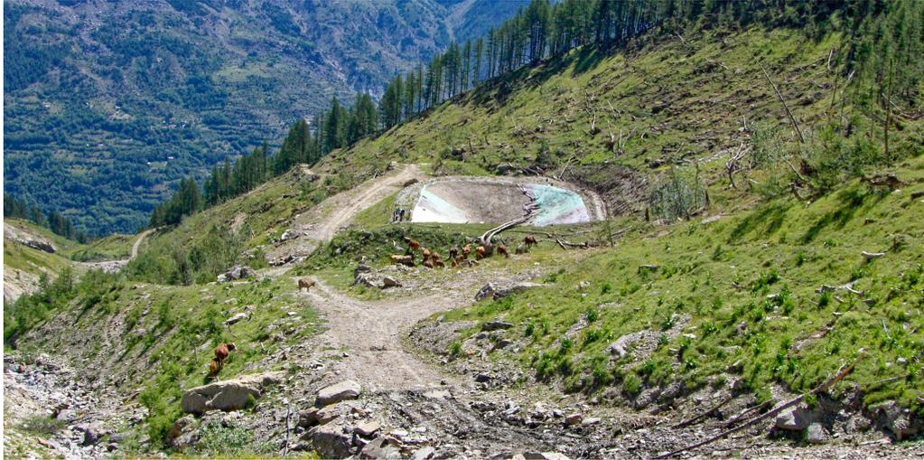
**Figure 3.9** – Retenue d’altitude située dans le bassin-versant de la Bouisse (station de Pelvoux, Hautes-Alpes, France) après qu’une avalanche est entrée dans la retenue et a expulsé le volume d’eau le 9 mars 2006. Source : (Evette *et al.*, 2011).
