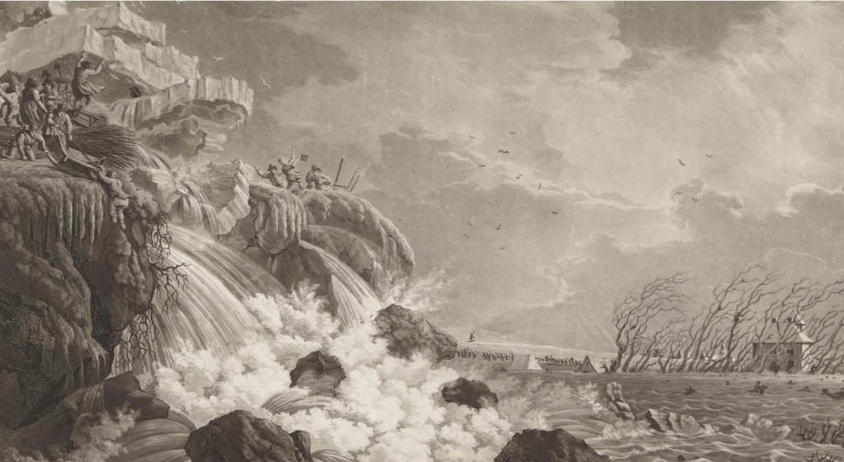
Rupture de digue. Exemple des Pays-Bas avec la construction de digues pour gagner sur la mer depuis le haut Moyen Âge. Rupture lors de grosses tempêtes de la mer du Nord ou bien manque d'entretien entraînant l'inondation des terres exondées
